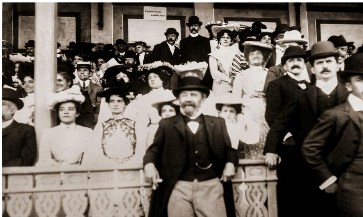
Fotografia 1 - Arquibancada do Velódromo (s.d.)
